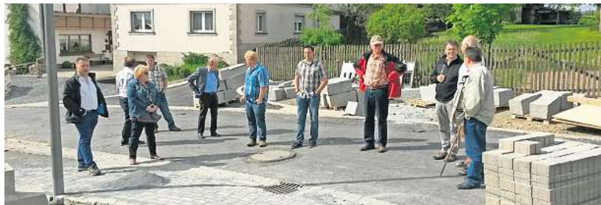
Ortstermin in Birnbaum: Die Mitglieder des Gemeinderats äußerten sich sehr positiv zum Baufortschritt an der „Langen Seite“.
